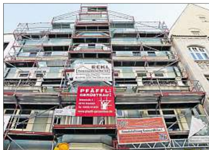
An der Baustelle des ehemaligen Schuhhauses Reindl in der Ludwigstraße wird bald wieder gearbeitet. Jetzt ist endgültig klar, dass dort die Burgerkette Hans im Glück einziehen wird. Foto: Eberl
